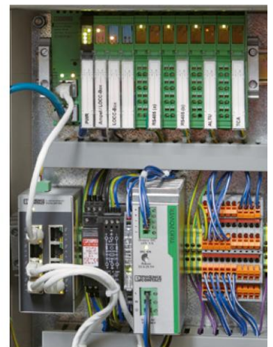
Uma visão para dentro da Central Box da máquina de perfuração de túneis
